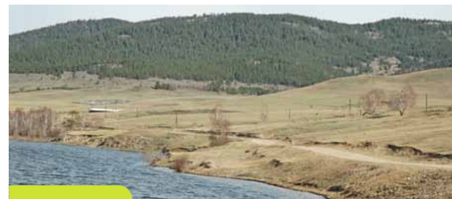
Водохранилище Калиновское на р. Галтайне
