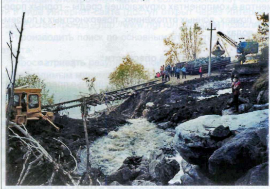
Рис. 2. Последствия схода селевого потока в июле 2001 г. на 117-м километре западного участка КБЖД
