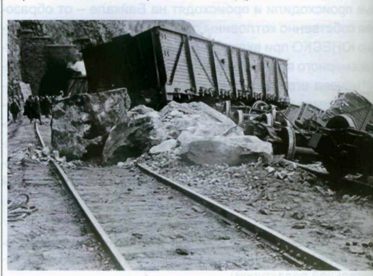
Рис. 3. Последствия обвала в мае 1941 г. у восточного портала тоннеля № 5 (87-й км КБЖД)
