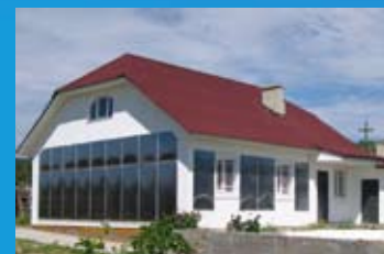
Жилой дом площадь СК 45 м 2 горячее водоснабжение и отопление
