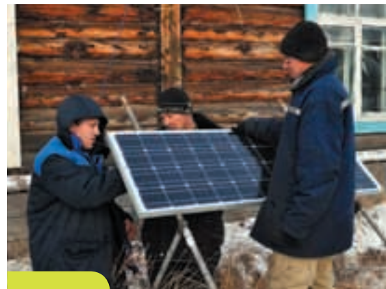
Установка солнечных батарей на метеостанции Ую
