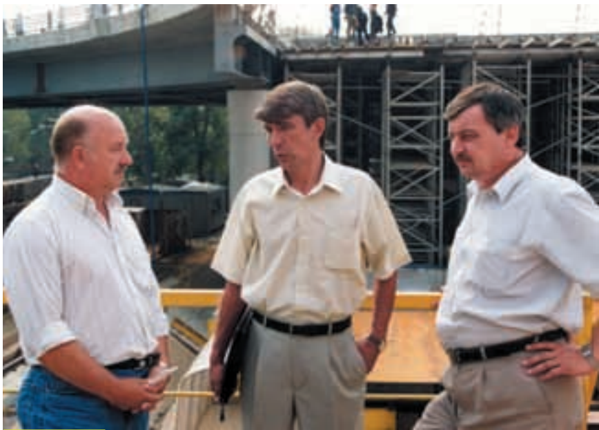
Строительство моста возле делового центра «Москва-Сити», г. Москва
