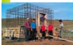
Этапы строительства ступы
